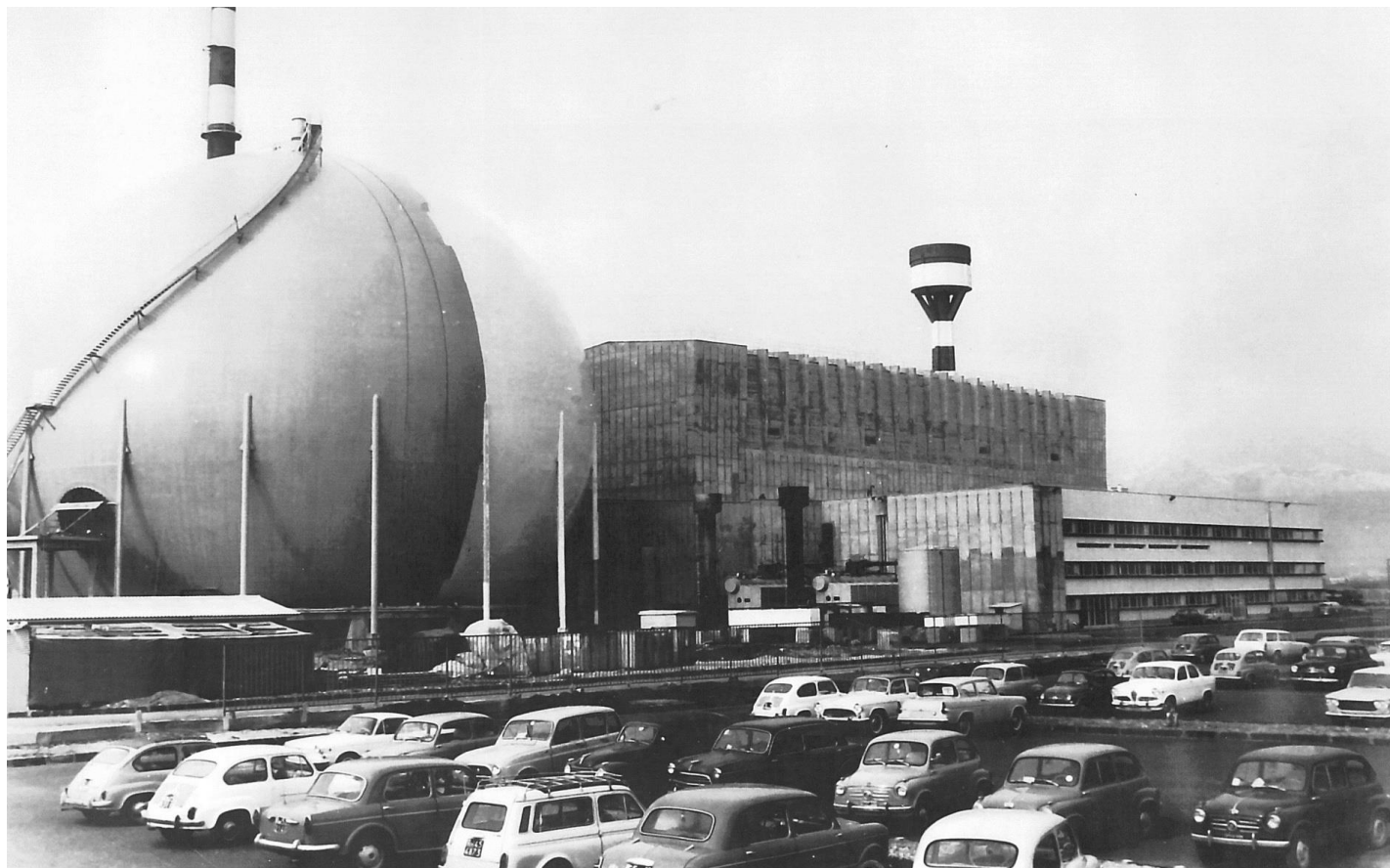
INTERNATIONAL GENERAL ELECTRIC OPERATIONS, S. A. FOR SOCIETA' ELETTRONUCLEARE NAZIONALE (SENN) CENTRALE ELETTRONUCLEARE DEL GARIGLIANO 150 000 KW (E) INSTALLATION
