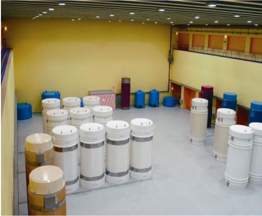
Cask dual purpose (trasporto-stoccaggio per HLW e combustibile irraggiato) (Zwilag, Svizzera)
