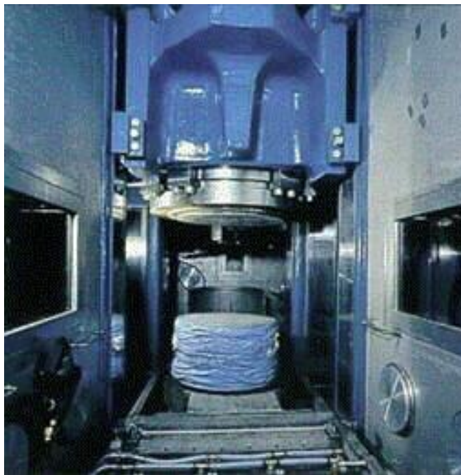
Supercompattatore dell'impianto CILVA (Belgio)
