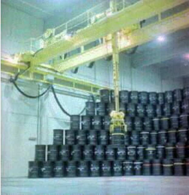
Stoccaggio temporaneo di fusti condizionati
